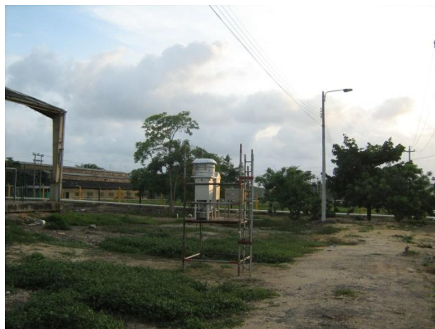
Foto 5.1 Ubicación estación de monitoreo CA1 (bodega DRI)
