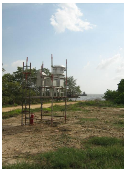
Foto 5.2 Ubicación estación de monitoreo CA2 (Separador API)
